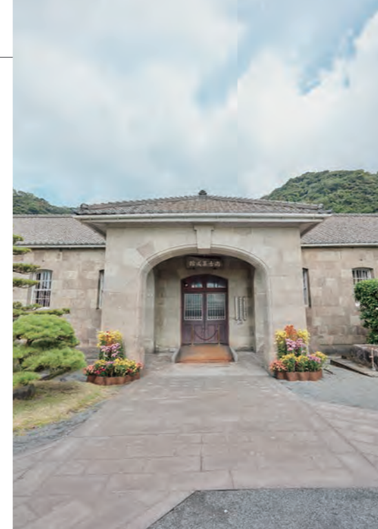
旧集成館機械工場 (1865) (現:尚古集成館)
