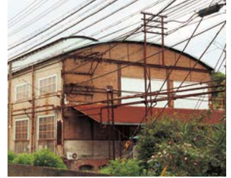
官営八幡製鐵所【八幡】 旧鍛冶工場（1900年）
