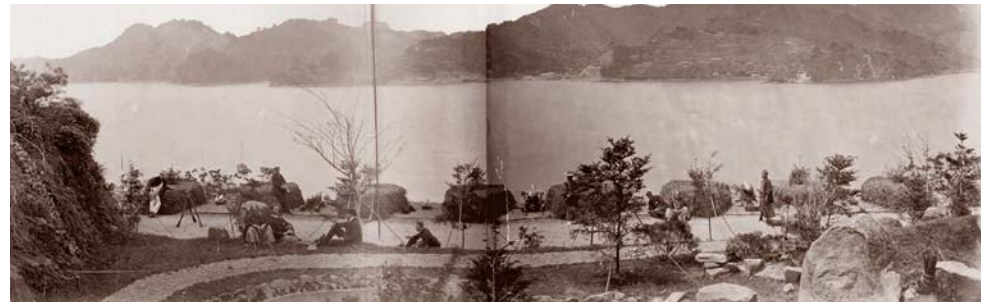
長崎港を見下ろすグラバー住宅に設置された砲台（1860年代）。 全ての船舶の往来が明瞭に観察でき、対岸に、長崎製鉄所を一望する。
